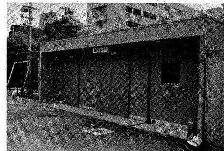
新築になった更衣室
